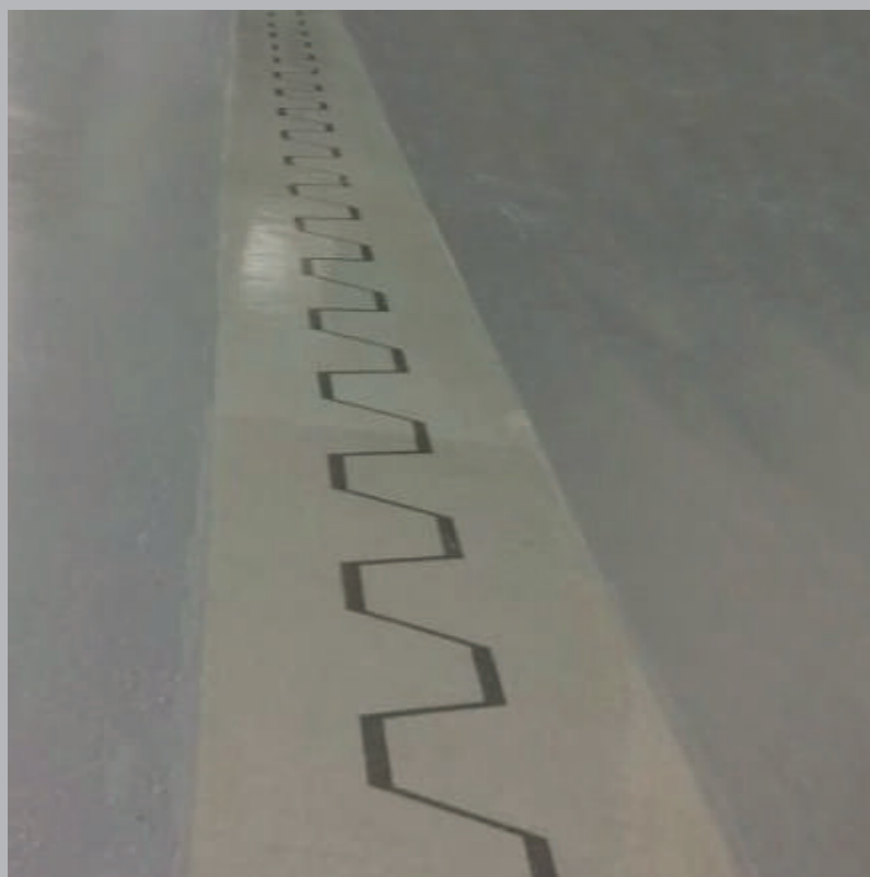
Smart Joint® su pavimento in resina finito
