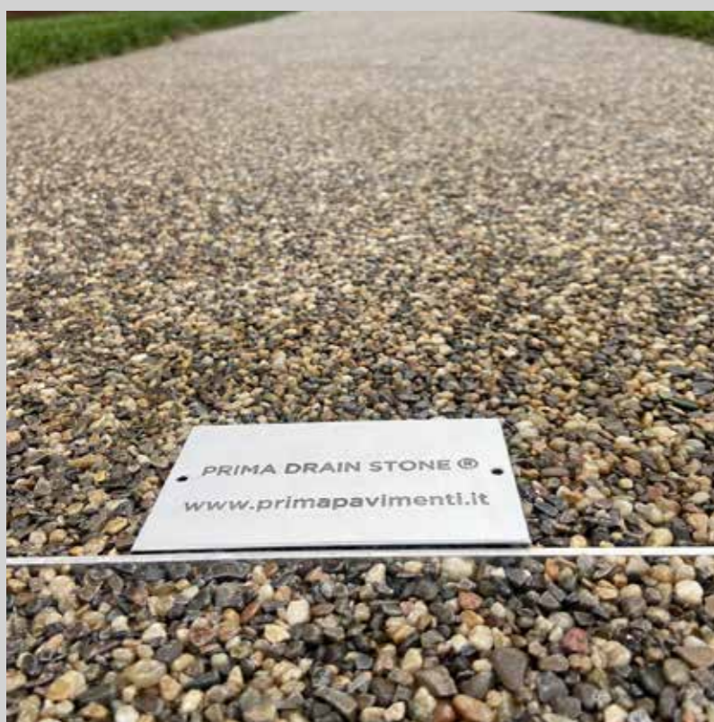
Vialetti di accesso pedonali e carrabili
